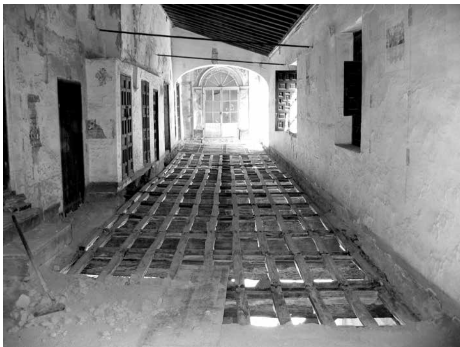
FIG. 2. Deambulatorio occidental alto. Consolidación del artesanado. Foto: Fernando Sánchez Navarrete.
